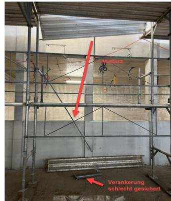
Als der Monteur zum dritten Mal in den Randbereich des Gerütes gelangte, um dort einen Kugelhahn zu öffnen, lösten sich schlagartig zwei Einlegeböden unterhalb des Mitarbeiters ähnlich einer Falltür und der Monteur stürzte zu Boden (Absturzhöhe 4m).
