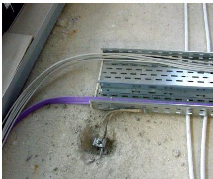
Nachträglicher Anschluss an Bewehrung mit verzinktem Cu-Band (Verbindungen so kurz wie möglich)
