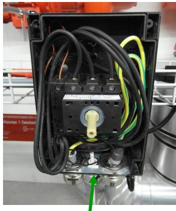
Schirmanschluss mit EMV-Verschraubungen und Kontaktplatte innen
